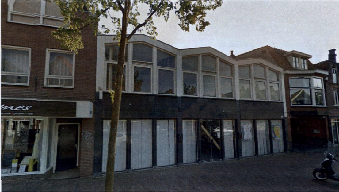
(Foto huidige bebouwing)
